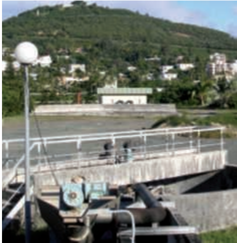
Station d'épuration à Nouméa, en Nouvelle-Calédonie.
