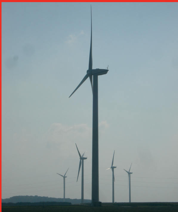
Parc éolien des Monts Bergerons 1 (France) 5 machines Repower MM82 Réalisation des postes de transformation 690V/20kV, du poste de livraison 20kV et du système de contrôle commande.
