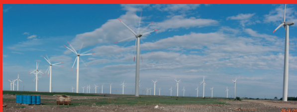
Réalisation Export 2008 Bulgarie - Parc de Kaliakra 35 machines Mitsubishi de 1 MW Réalisation du poste électrique 110kV/20kV et système de contrôle commande (Scada).
